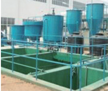
电镀废水治理工程
